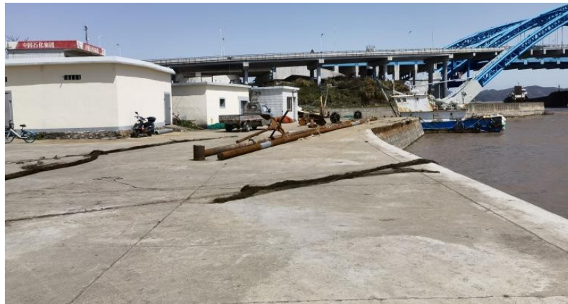
图 2.6.4-3 海塘内侧工业厂区实例
