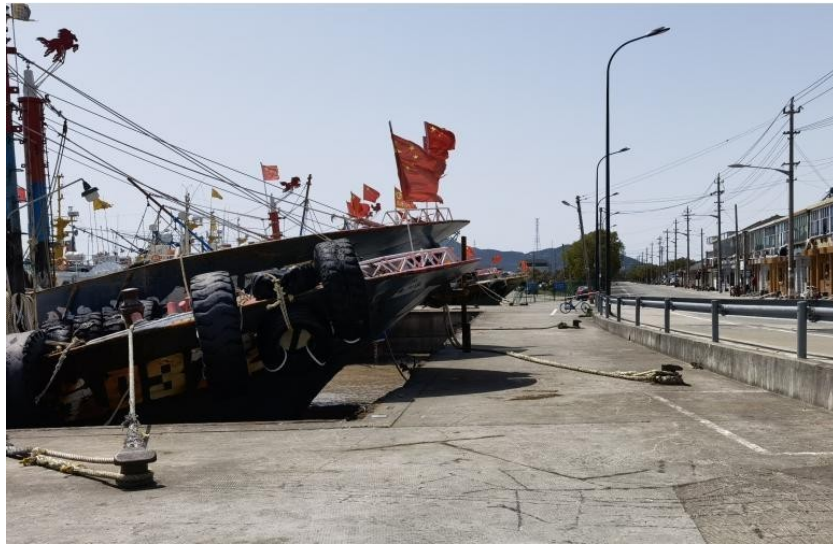
图 2.6.4-1 海塘内侧密布房屋建筑和渔船实例
