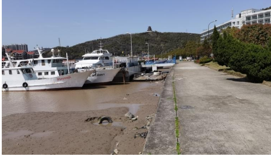
图 2.6.3-1 临海侧渔业码头实例
