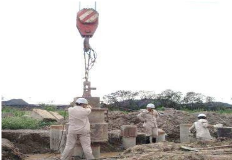
图 6.3-5 混凝土灌注桩施工图
