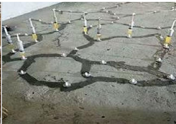
现场放线排版
