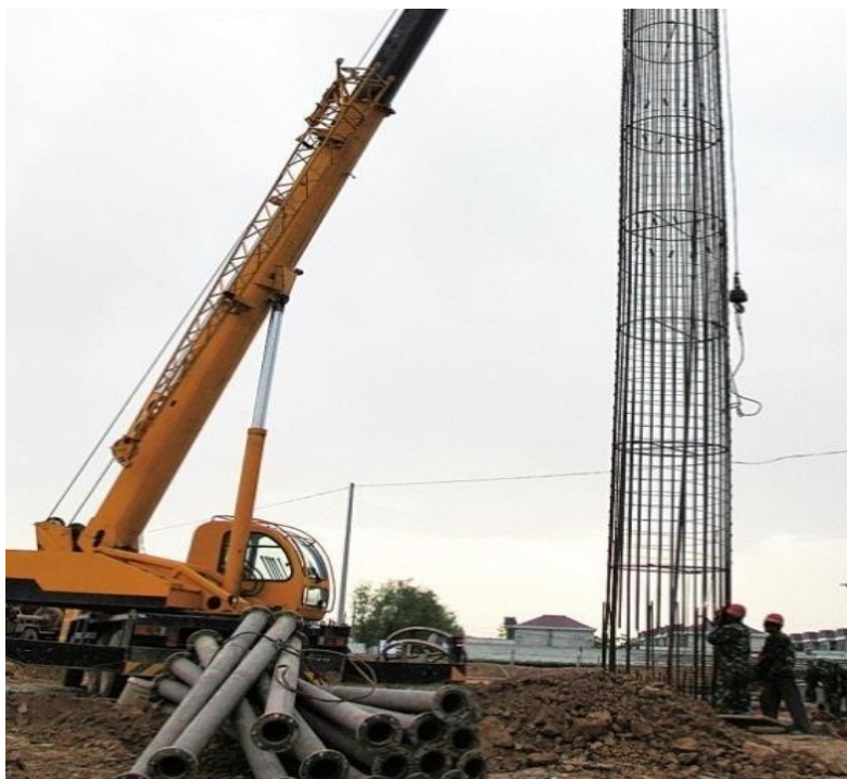
图 6.3-4 钢筋笼吊放施工图2
