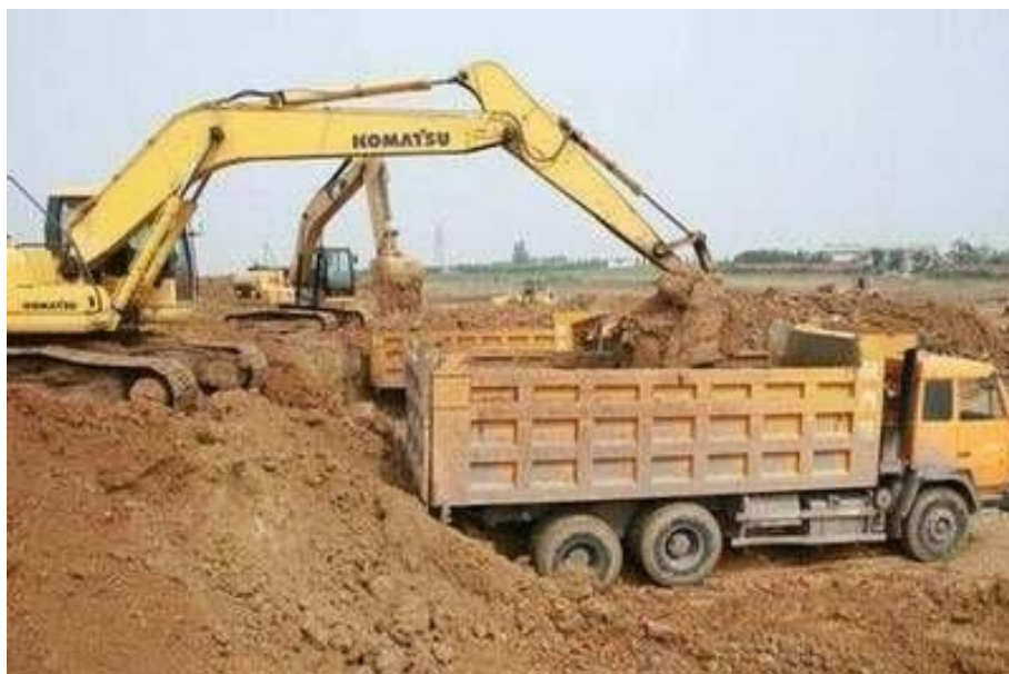
图 6.1-1 土方开挖施工图
