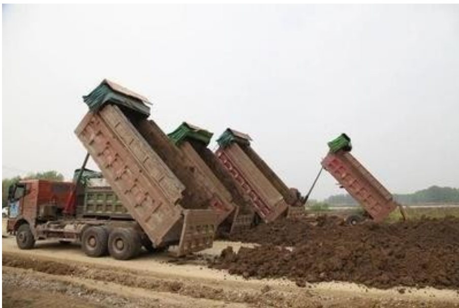
图 6.13-1 土方铺料施工图
