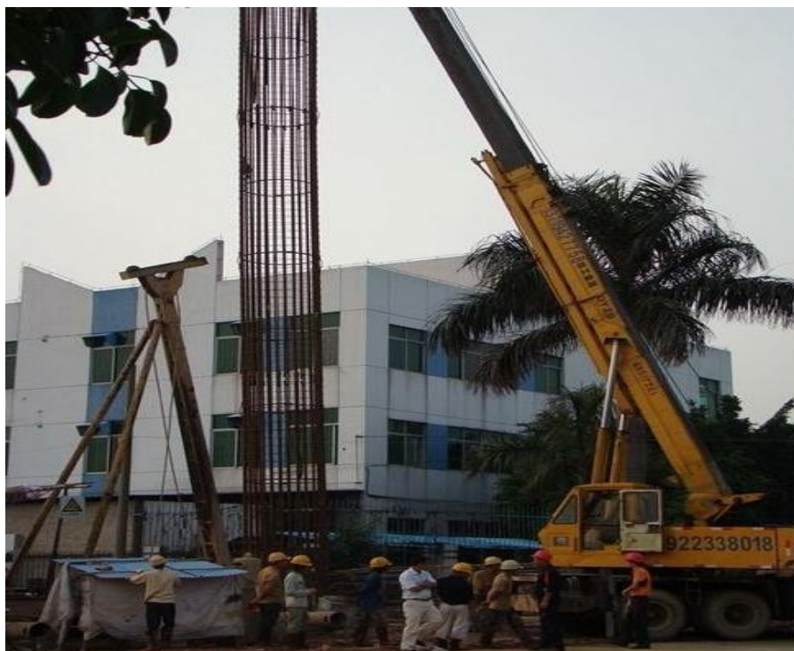
图 6.3-3 钢筋笼吊放施工图1
