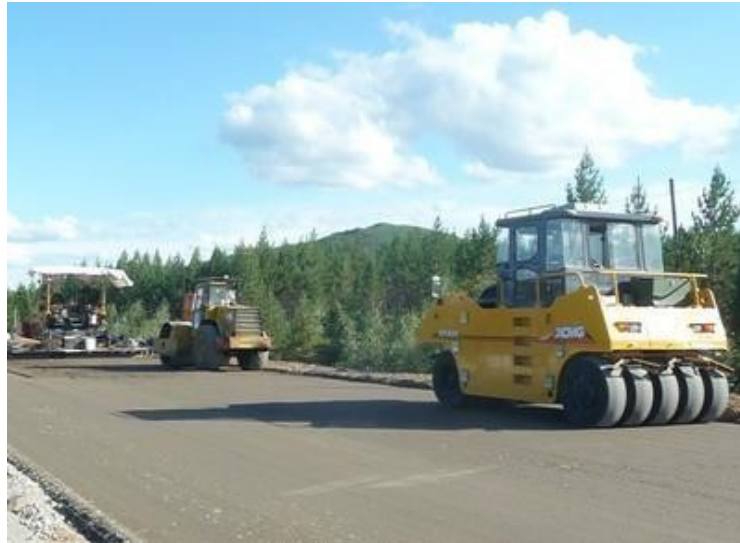
图 6.11-1 水稳层施工图
