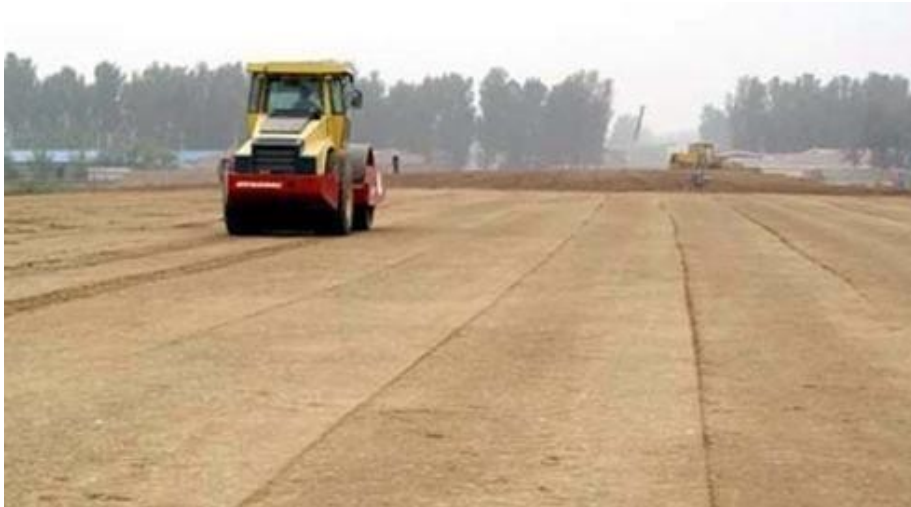
图 6.13-2 土方碾压施工图
